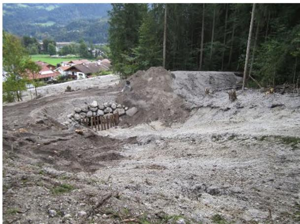
Abb. 1: Schutzbauten an der Nordflanke des Grünsteins in Schönau am Königssee: In einem bis zu sieben Meter tiefen Auffangbecken können fünf Rohre das herabrauschende Wasser geordnet ableiten
