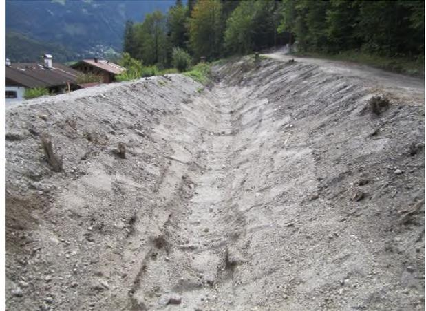
Abb. 4: Jetzt ist das Auffangbecken bis zu vier Meter tief.
