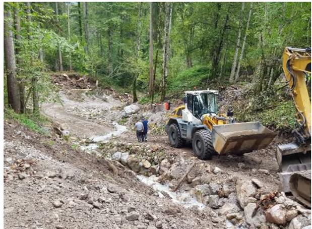
Abb. 6: Mit schwerem Gerät schaffen Arbeiter Geröll und Wildholz aus dem Klingerbach. Anschließend muss die Ufersicherung neu angelegt werden.
